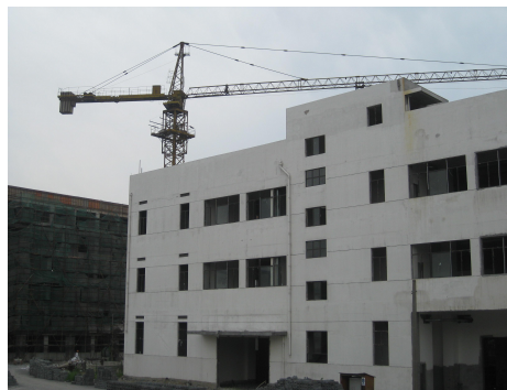
保温砌块工程应用
